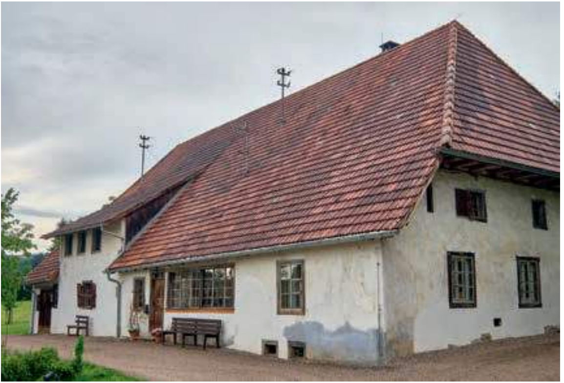
Hotzenhaus, Ansicht von Süden
